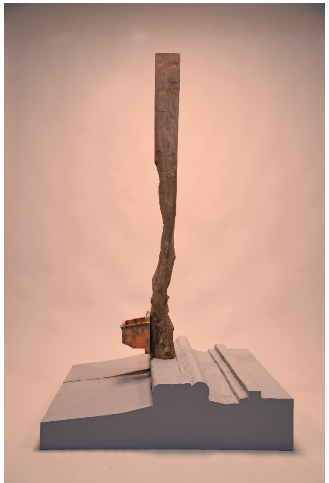
写真3 牛が齧った牛舎の柱
