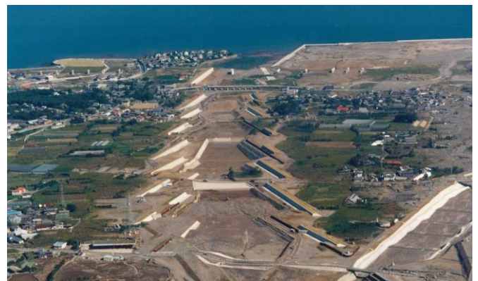
写真 4 導流堤の建設(1995 年撮影)
