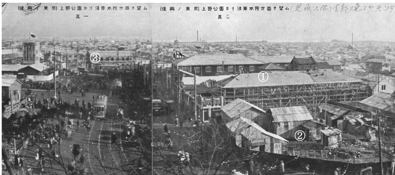
図3 建設中の井筒屋旅館のバラック(1924年2月以前)
