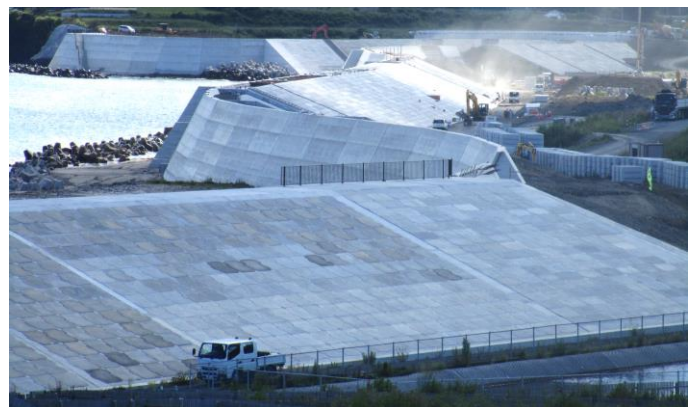
写真1 気仙沼市階上・大谷地区の防潮堤工事
