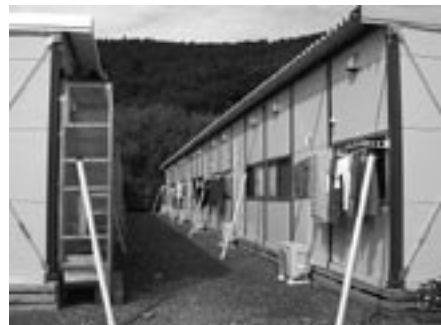
人のざわめきが聞こえない仮設住宅（石巻市内）
