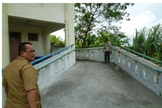
写真11 屋上への避難路
