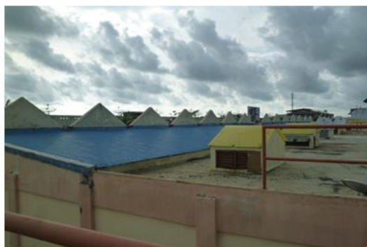
写真 8 避難場所屋上
