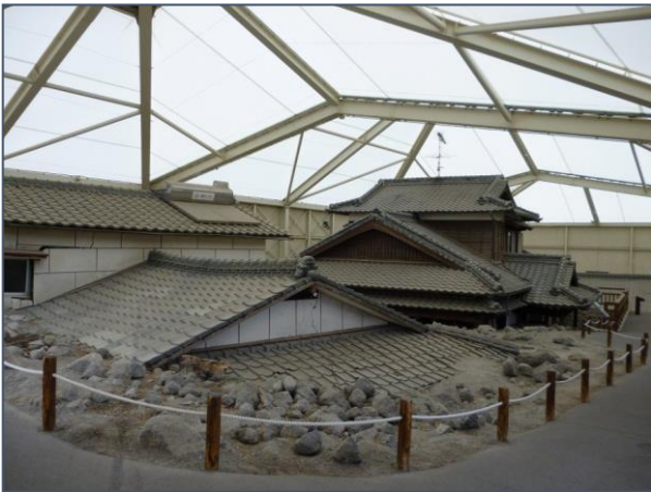
写真5 土石流に埋没した住宅群（南島原市）
