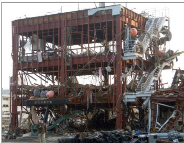
写真1 防災対策庁舎（南三陸町）
