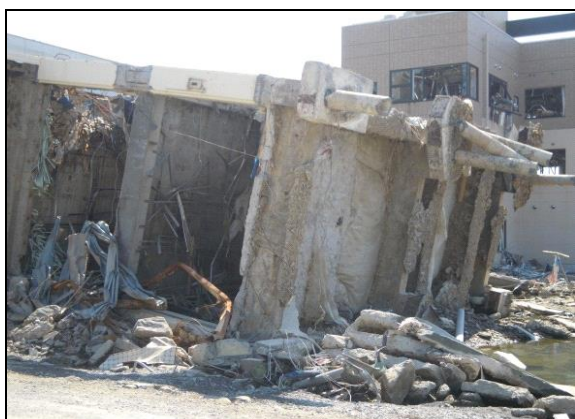
写真2 転倒したRC造の交番（女川町）
