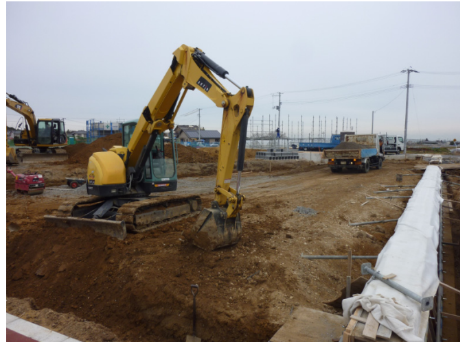
写真2 住民持ち込み型の団地での造成工事
