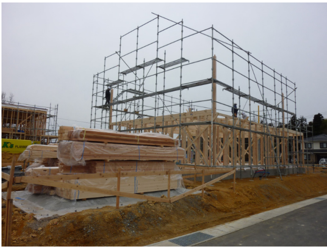
写真1 集団移転先の団地での住宅再建工事
