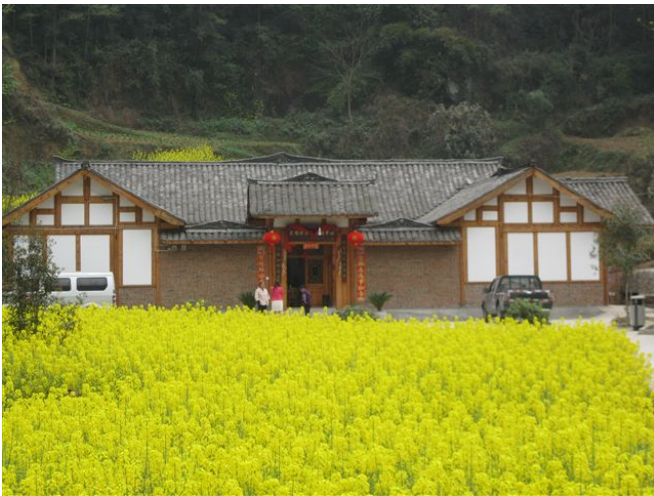
写真1 CODEが建築した伝統木造建築のコミュニティセンター(撮影:吉椿 2013年3月15日)
