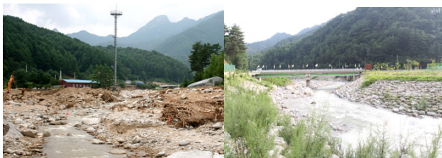
(被害の後) (復旧の後)
