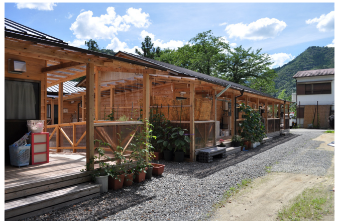
写真3 十津川村の木造仮設住宅
