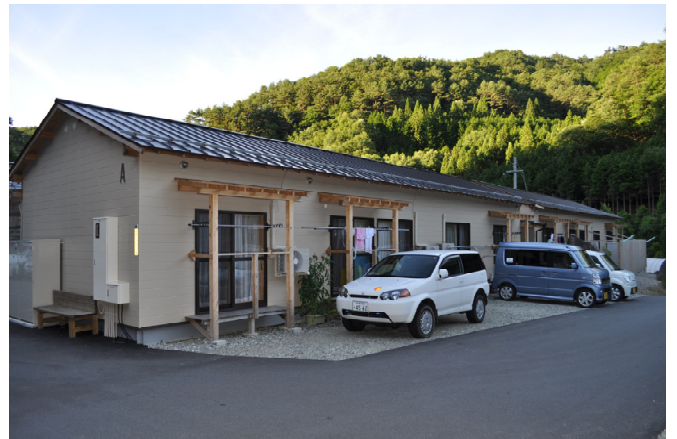
写真 4 野迫川村の木造仮設住宅 外壁が窯業系サイディングとなっている
