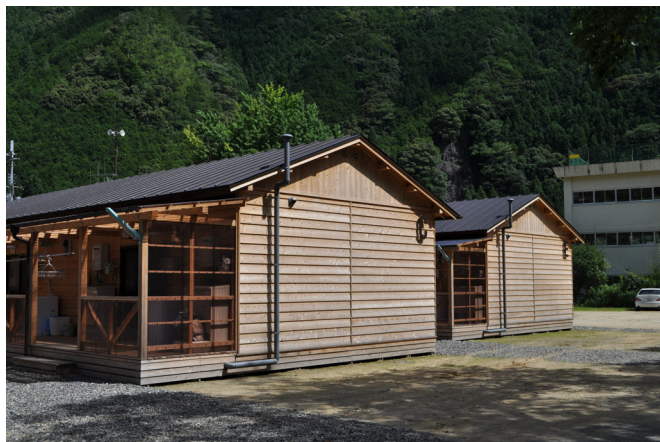
写真2 奈良県の木造仮設住宅(十津川村平谷)
