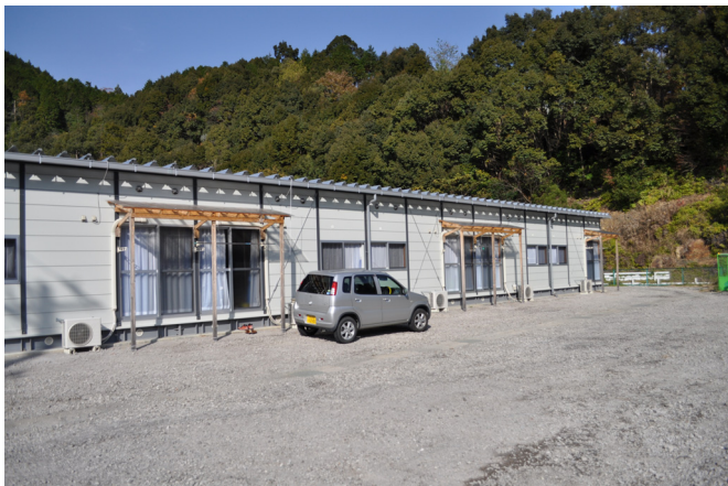
写真1 和歌山県の鉄骨プレハブ造仮設住宅(新宮市熊野川町)
