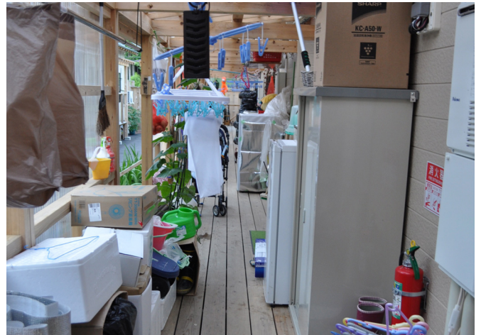
写真 5 野迫川村の仮設住宅の共用廊下 ポリカで囲われており内部化している
