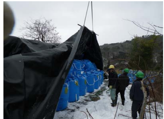
図3 仮置き場の状況 (積まれたフレコンに遮水シートをかける様子)
