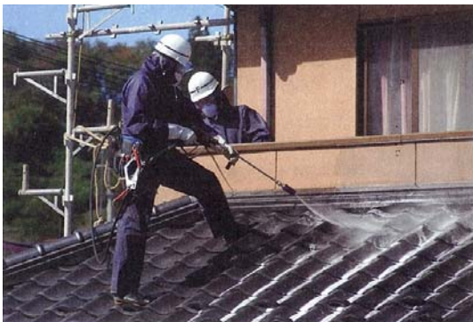
図4 屋根の瓦除染の例（高圧洗浄） （環境省 除染関係ガイドライン 平成23年12月 第1版より）
