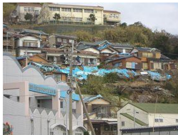
写真-1 被災した斜面地
